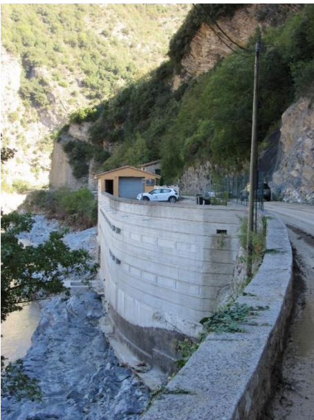
Photo de la station d'épuration de Breil-sur-Roya
