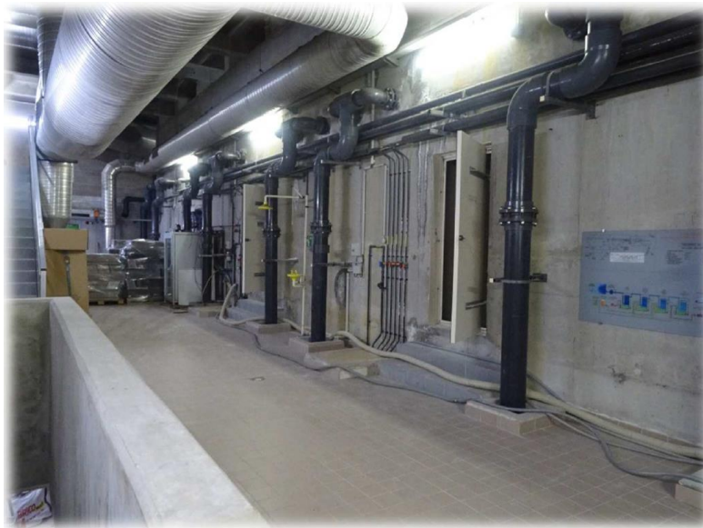
Accès aux portes des tours de désodorisation de la station d'épuration de Menton
